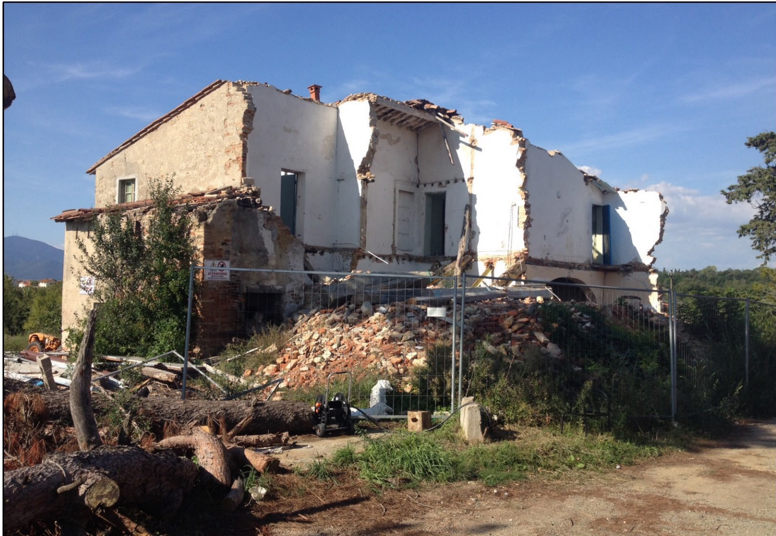
Foto n. 05 - vista dell'Unità Minima di intervento n. 1 da Est
